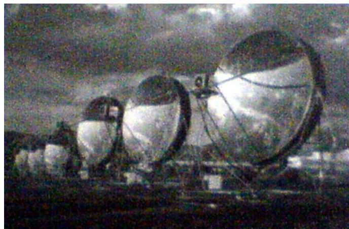
شکل (5-6) نمایی از یک نیروگاه برق بشقابی - استرلینگ
