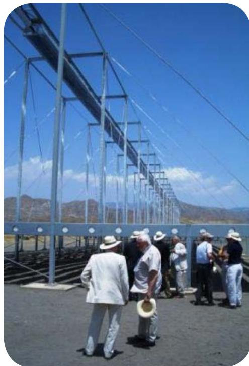
متر می باشد. از یکطرف لوله دریافت کننده آب وارد شده و از طرف دیگر بخار خارج می شود و نیازی به سیستم های جانبی اضافی نیست.
